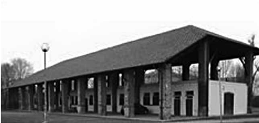
Cascina Monluè: un edificio già ristrutturato
