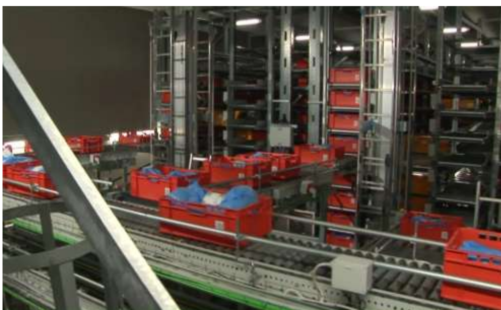
Figura 11. Stoccaggio casse nel grande magazzino automatico
